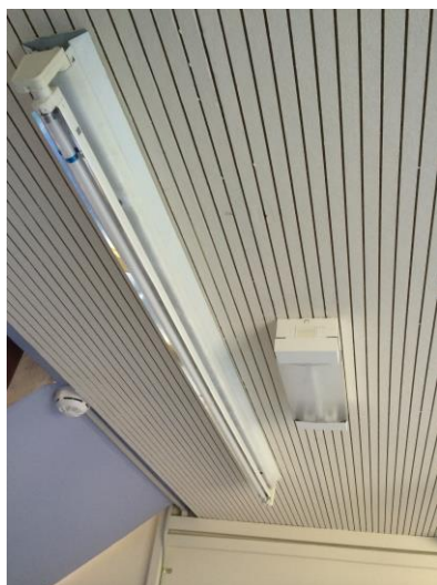
Afbeelding 5.27: Foto van een trappenhuis met "gewone" verlichting in de vorm van een tl-balkarmatuur en een noodverlichtingsarmatuur (Woningstichting Samenwerking).
