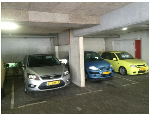
Afbeelding 5.14: Foto van een parkeergarage onder een wooncomplex (Woningstichting Samenwerking).
