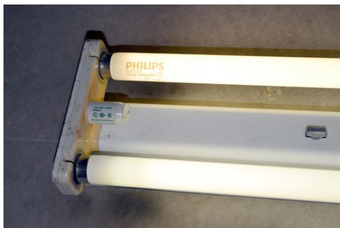
Afbeelding 4.4: Foto van een balkarmatuur met conventioneel voorschakelapparaat. De starter duidt op een mogelijke besparing.
