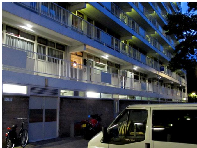
Afbeelding 5.24: Foto van dezelfde galerij met op de eerste verdieping de nieuwe led-armaturen en op bovenliggende verdiepingen de oude verlichting (Woonstad Rotterdam). De laatste drie armaturen op de eerste galerij branden op een laag niveau.
