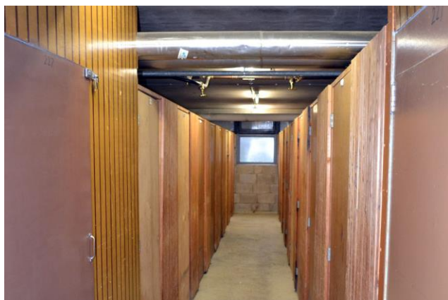
Afbeelding 5.15: Foto van een rechte gang met loodrecht daarop geplaatst bergingen afgescheiden met manshoge tussenwanden (Woonstad Rotterdam).
