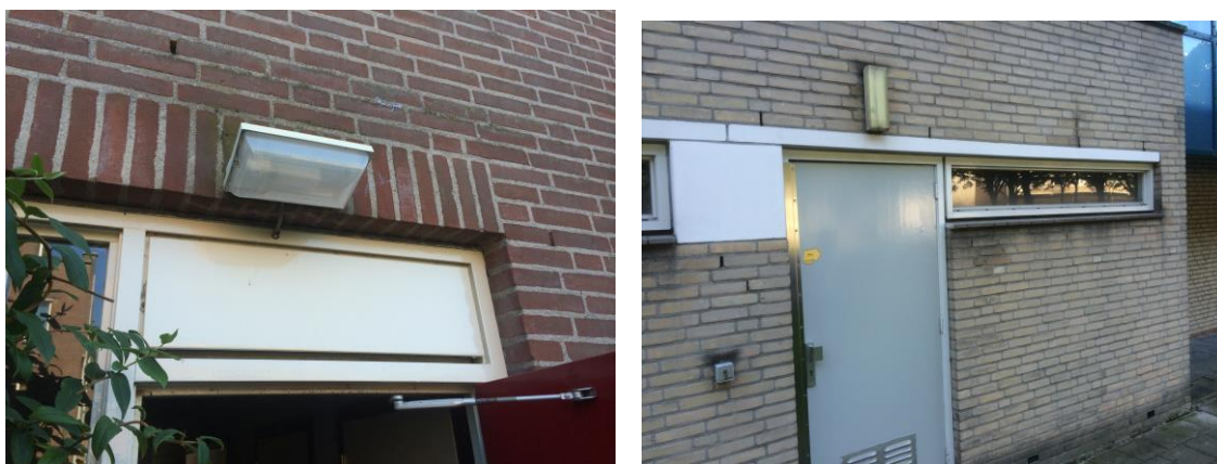
Afbeelding 5.7: Foto's overdag van een achterdeur met links een 18 W beveiligingsarmatuur met een lichtsensor (Woningstichting Samenwerking) en rechts een generiek 8 W armatuur.
